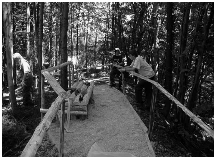
Ein Abschnitt kurz vor der Fertigstellung
