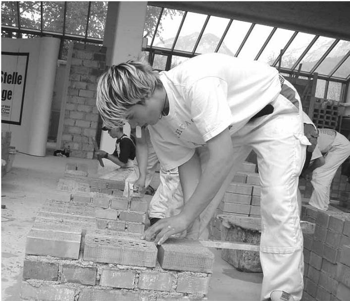
In der Bauakademie erstellten die 14 Bautechniker eine Mauerecke aus NF-Steinen mit 10 Schichten
