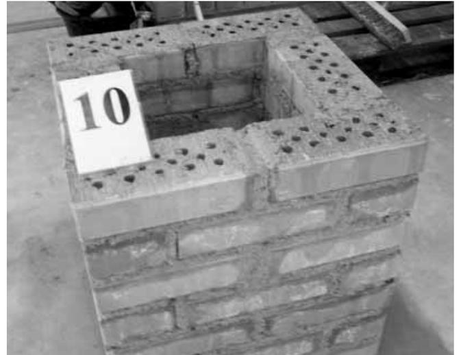
Werkstück BAU: Ziegelverband
