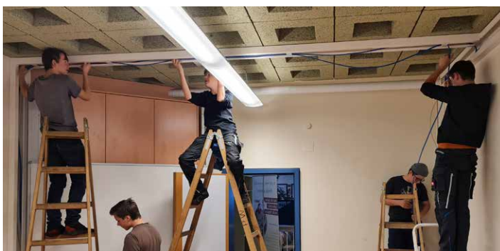
Foto: Schüler der Fachbereiche Elektro und KFZ beim Verlegen von Netzwerkkabel
