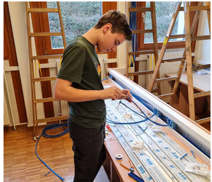
Foto: Schüler des Fachbereiches Elektro beim Anschließen einer Netzwerkdose
