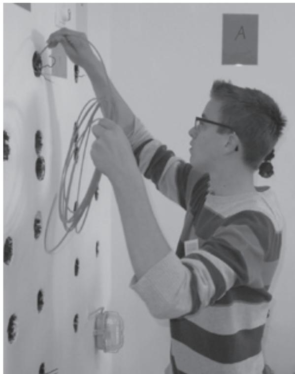
Wechselschaltung mit Schukosteckdose in „Unter-Putz-Ausführung“
